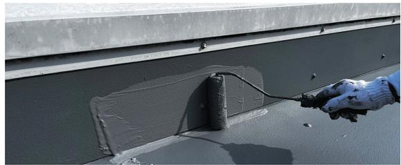
浸水対策の基本は、前段でも触れたクラックの確認です。幅が0.3mmを超えるクラックは建物内部への浸水が始まっている恐れがあり、早めの補修が必要です。浸水が進むと、木部の膨張や腐食が起り、躯体の強度が著しく低下するほか、RC造の場合には内部の鉄筋が錆びて膨張し、周囲のコンクリートが破壊される「爆裂」が起こります。コンクリート内部へ浸水時は、亀裂のそばに白い模様が現れる「エフロレッセンス(白華現象)」が見られるため、危険信号として押さえておきましょう。
